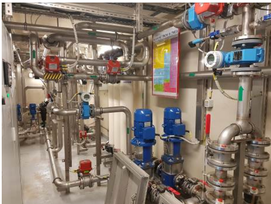
Slika 12: Ultrafiltracija pitne vode na Jelovcu
