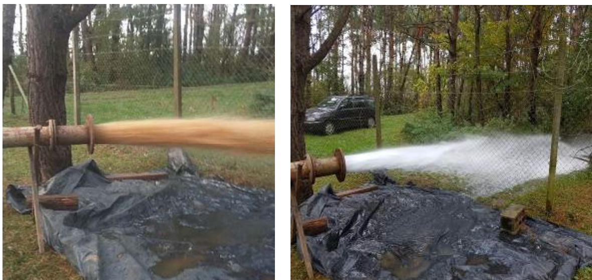
Slika 16: Čiščenje vodnjakov v Šikolah
