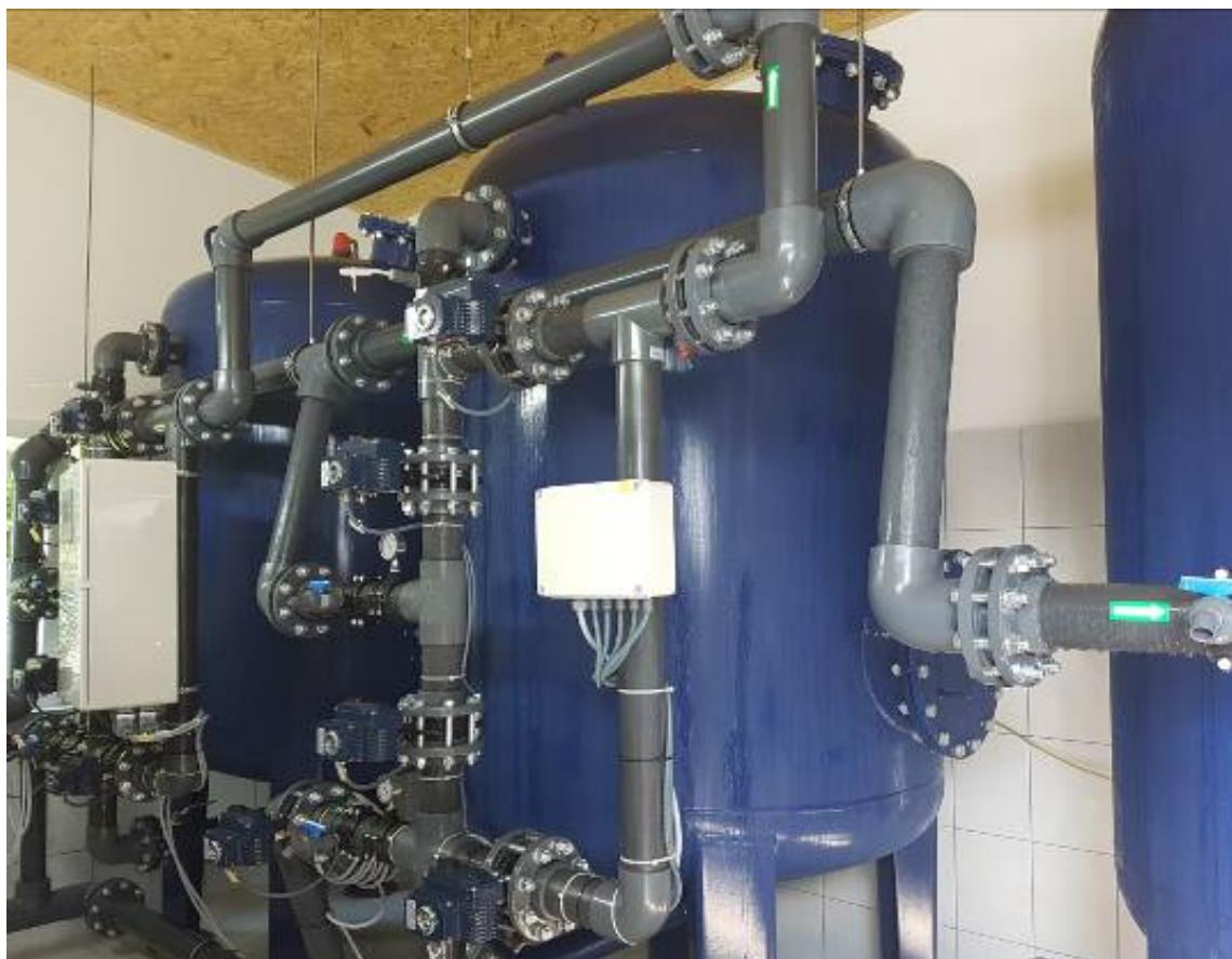
Slika 26: Postrojenje deferizacije in demanganizacije
