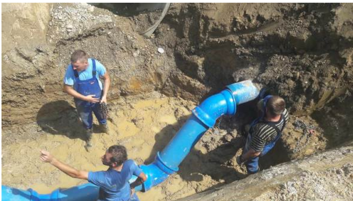
Slika 1: Izvedba sifona DN 300, 2017
